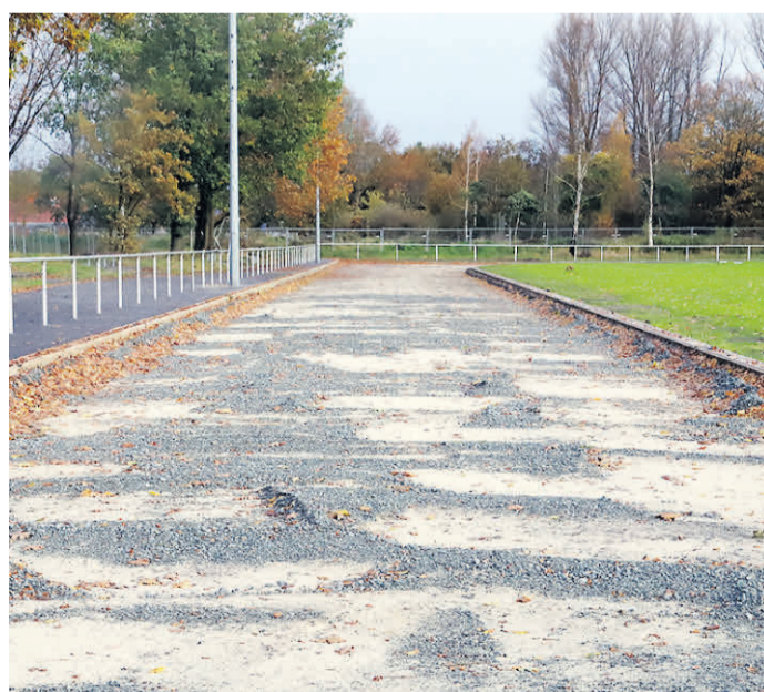
Weiterhin Baustelle: Auf der 400-Meter-Rundlaufbahn im Sportpark musste der fehlerhaft eingebrachte Schotter wieder entfernt werden.
